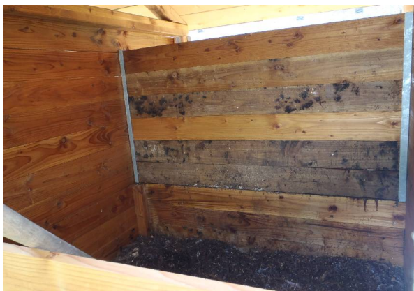
Compartiment de maturation juxtaposant la chambre de fermentation
