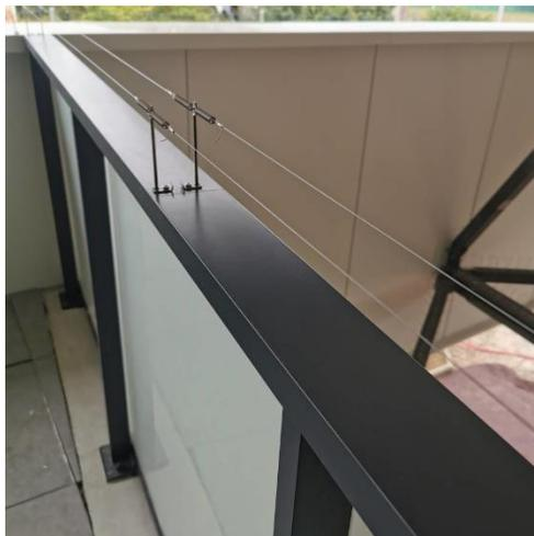
Figure 29 : Câble en inox tendu sur un garde corps pour lutter contre les pigeons en ville (©provence-nuisibles.fr)
